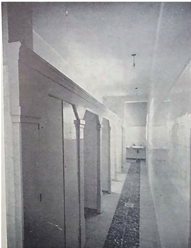
Foto 7. “Instalación sanitaria del Hospital de Toxicómanos”, tomado de Departamento de Salubridad Pública. Memoria de las labores realizadas durante el periodo comprendido entre el 1 de septiembre de 1934 y el 15 de julio de 1935 . México, 1936, p. 22.
